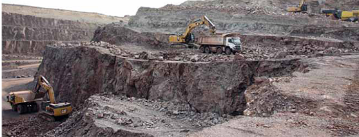
Baumaschinen verteilen sich auf den vier Sohlen.
